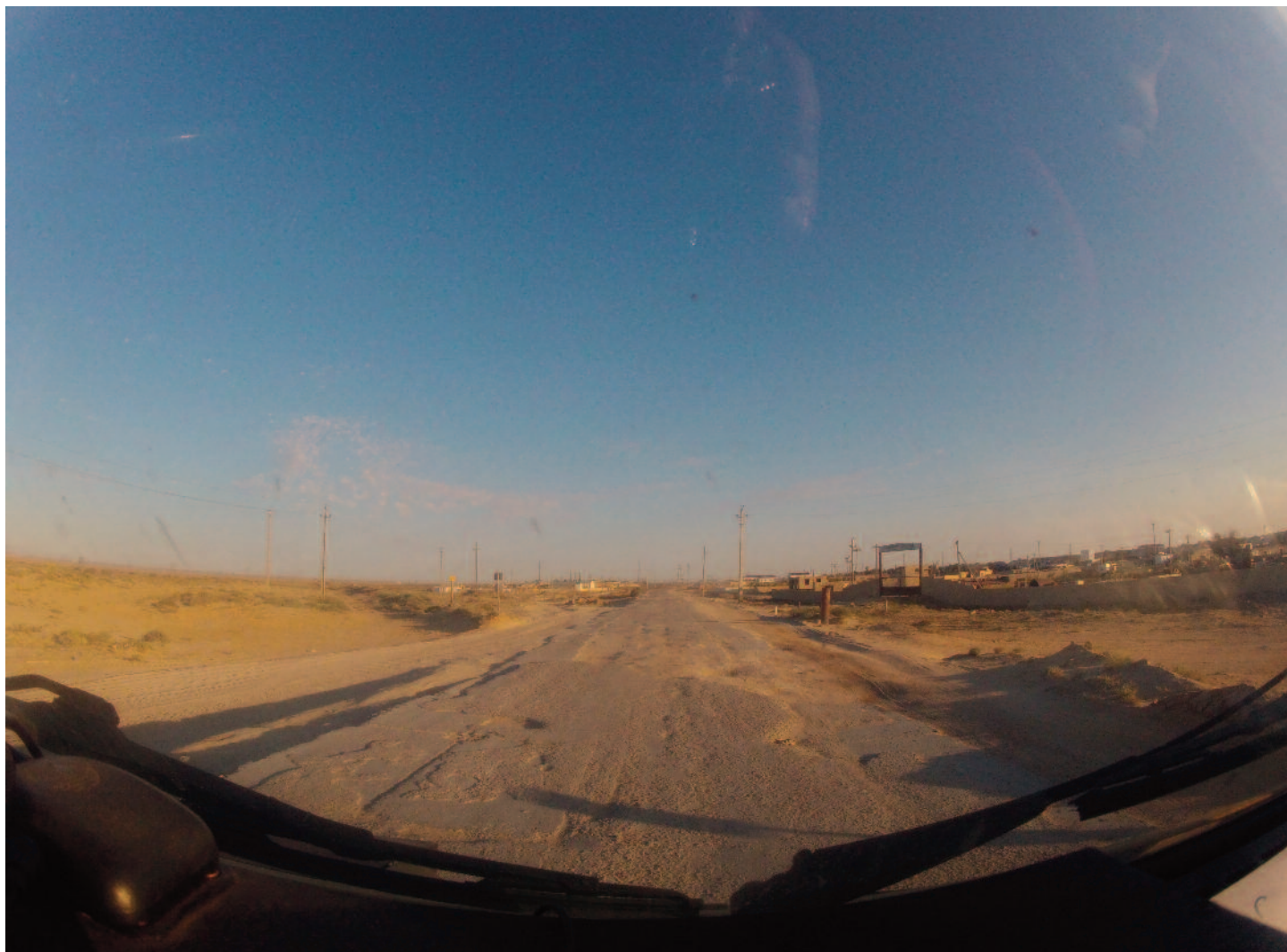
Uzbekistan - strada asfaltata per Samarkanda
